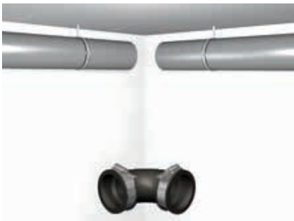
Rohrstück heraustrennen. Rohrhalterung lösen.
